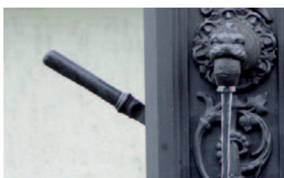
Trinkwasserbrunnen um das Jahr 1900
