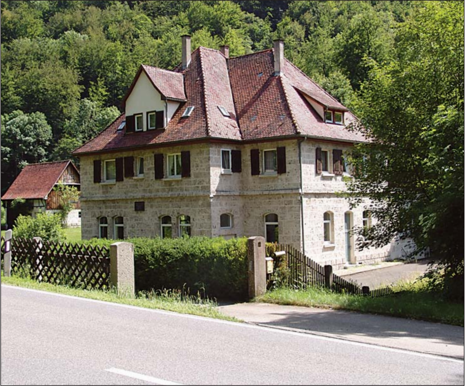
Pumpwerk Enge Vordere Albgruppe
