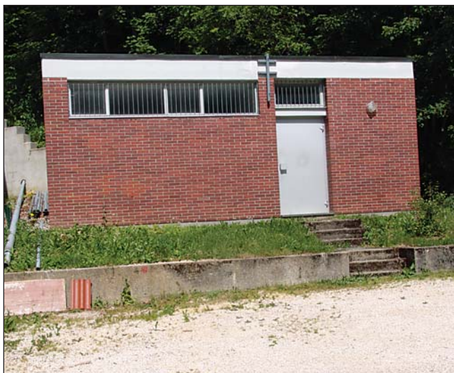
Ehemaliges Pumpwerk Seeburg
