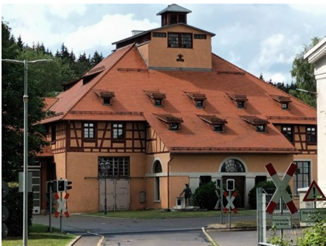
Abbildung 2: Das historische Hochofengebäude des Hüttenwerks Lauchenthal, von 1708 bis 1879 in Betrieb (Foto: Markus Fiederer, 2023)
