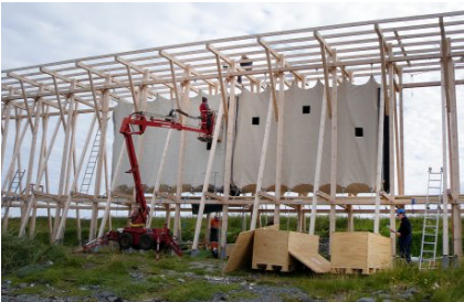
Montage des zweiten 6 m Elements (Golle/Plauen) Knut Arne Vang/ http://www.vegvesen.no/Vegprosjekter/Om+vegprosjekter/Turistveger/Nyheter/stor-aktivitet-på-s...
