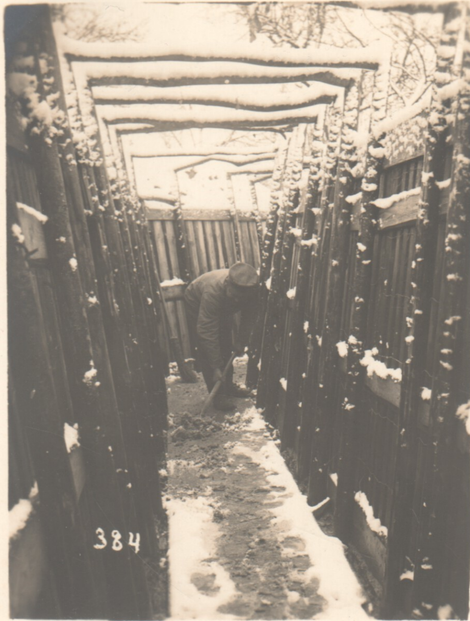
Laufgraben in Niederanpach.
